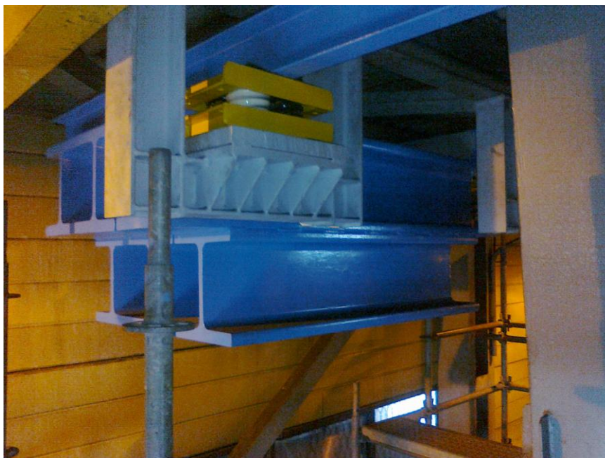
Rys. 2: Podparcie ramy wstrząsarki na wibroizolatorach (2- stopień wibroizolacji).
