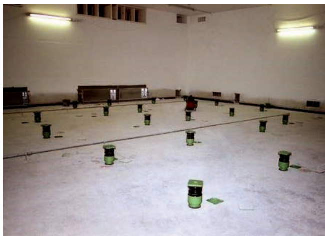
FOT. 1. Podłogi pływające zwiększają izolacyjność akustyczną stropów
