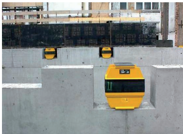
FOT. 2. Wibroizolatory GERB znacząco redukują amplitudy drgań w budynkach
