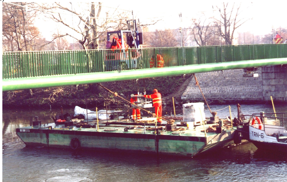
Rys. 5. Przebieg montażu tłumików w \frac{1}{4} (a) i w \frac{1}{2} (b) rozpiętości przęsła
