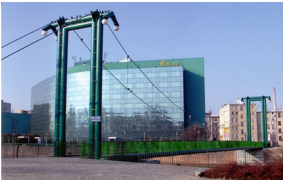
Rys. 2. Ogólny widok kładki po przebudowie
