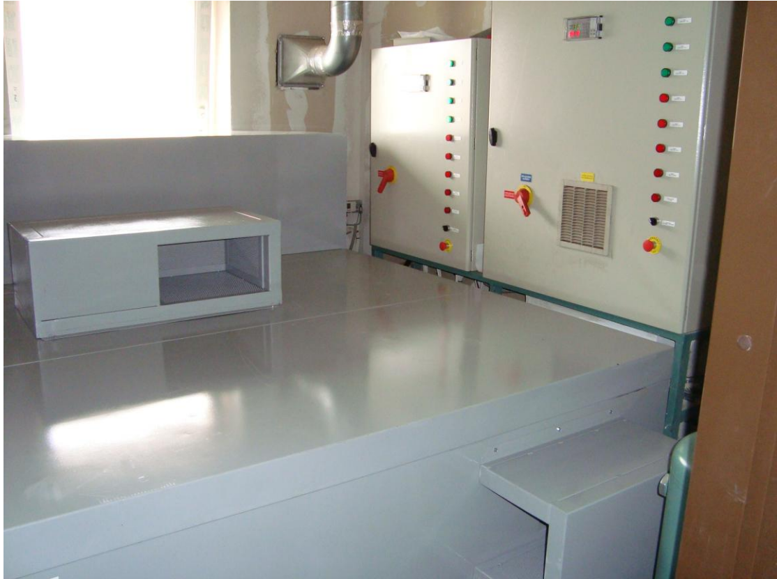
Rys.2. Obudowa dźwiękochłonna- izolacyjna zespołu sprężarek
