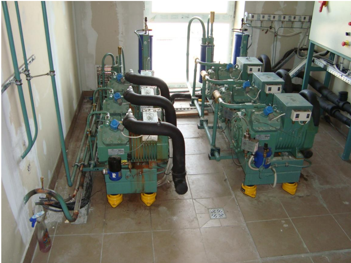
Rys.1. Wibroizolatory sprężynowe dla elastycznego posadowienia sprężarek.
