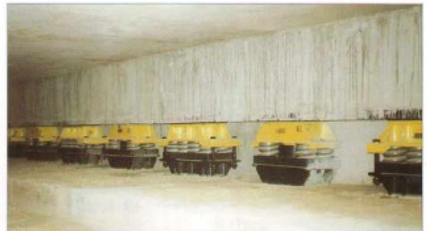
Wibroizolatory po zamontowaniu
