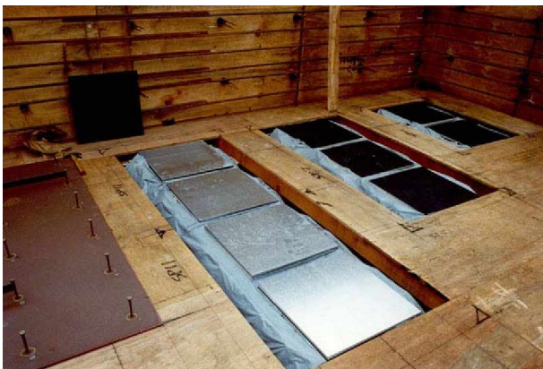
Wibroizolatory wbudowane w podłogę
