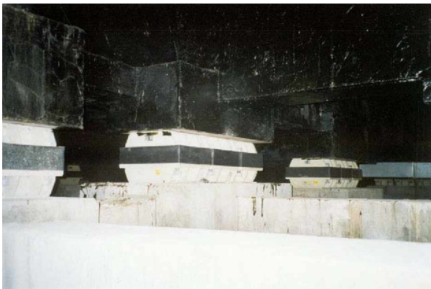
Zainstalowane wibroizolatory
