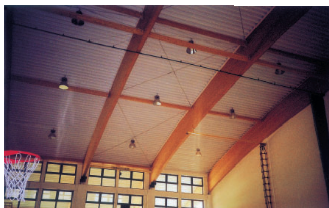
Fot. 1 Powierzchnie ścian i sufitu sal gimnastyczna jednej ze szkół w Konstancinie-Jeziornej otynkowane gruboziarnistym tynkiem akustycznym (SonaSpray K-13)
