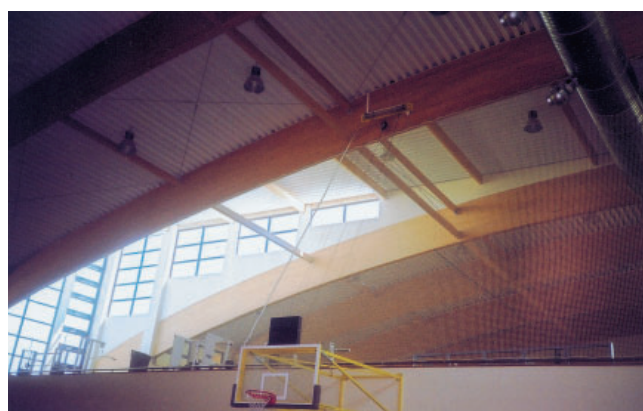
Fot. 1 Powierzchnie ścian i sufitu sal gimnastyczna jednej ze szkół w Konstancinie-Jeziornej otynkowane gruboziarnistym tynkiem akustycznym (SonaSpray K-13)
