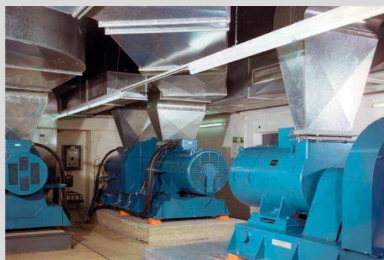
Rys. 6. Wibroizolacja urządzeń klimatyzacyjnych
