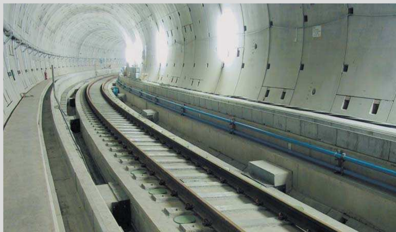
Rys. 18. Wibroizolacja torowiska w metrze
