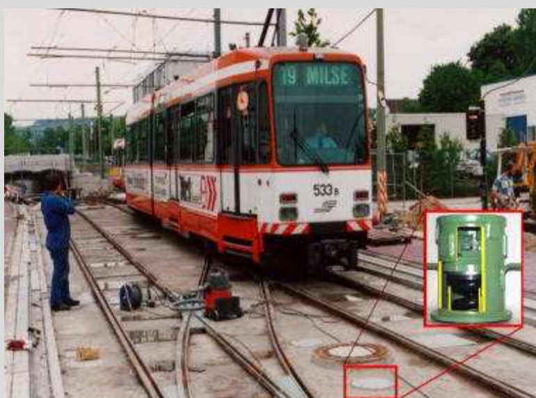
Rys. 19. Wibroizolacja torowiska tramwajowego
