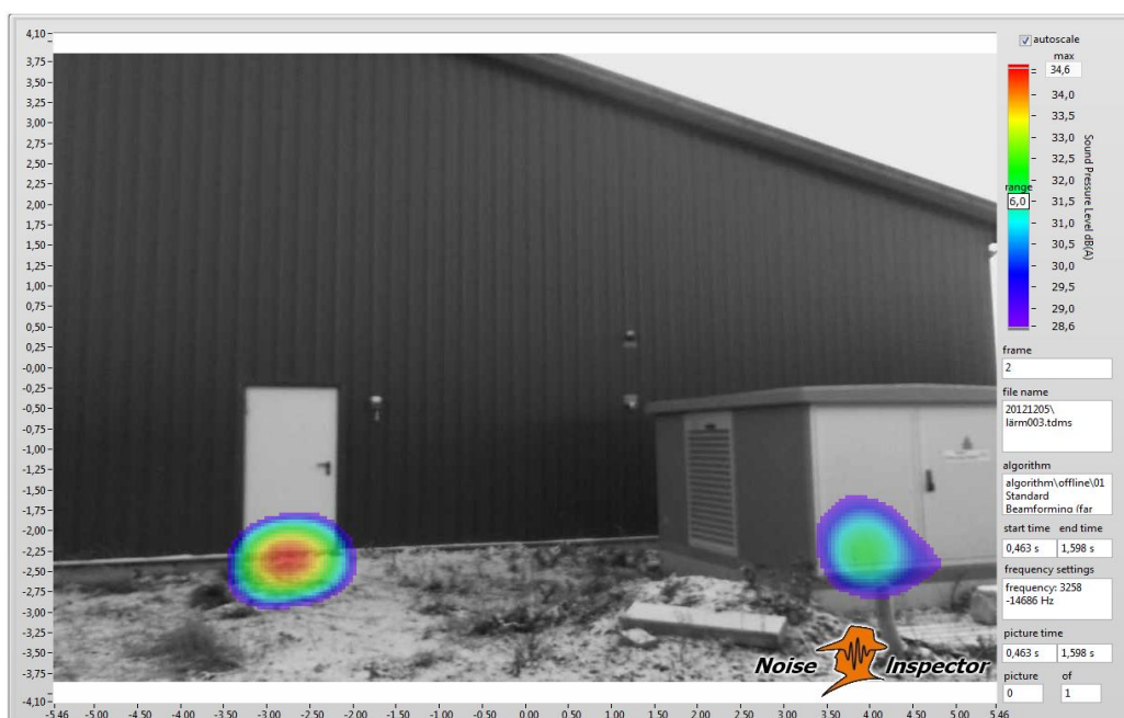
Rys.2. Drzwi w hali przemysłowej
